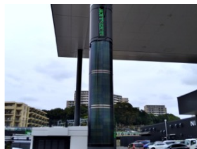
キャノピー柱に設置した太陽電池
